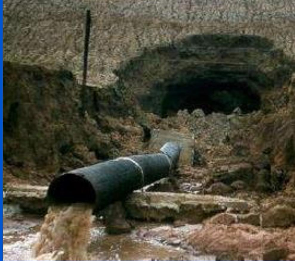
**FALLA POR EROSIÓN INTERNA A LO LARGO DE LA TUBERÍA DE DESCARGA**
